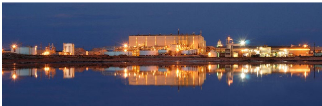
Die White Mesa Mill ist aktuell die einzige funktionstüchtige und laufende, konventionelle Uran-Verarbeitungsanlage in den gesamten USA.
